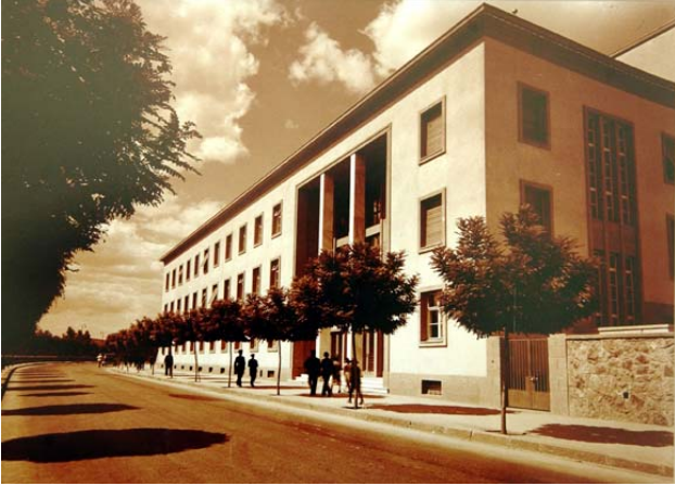
安卡拉电台中心主楼
